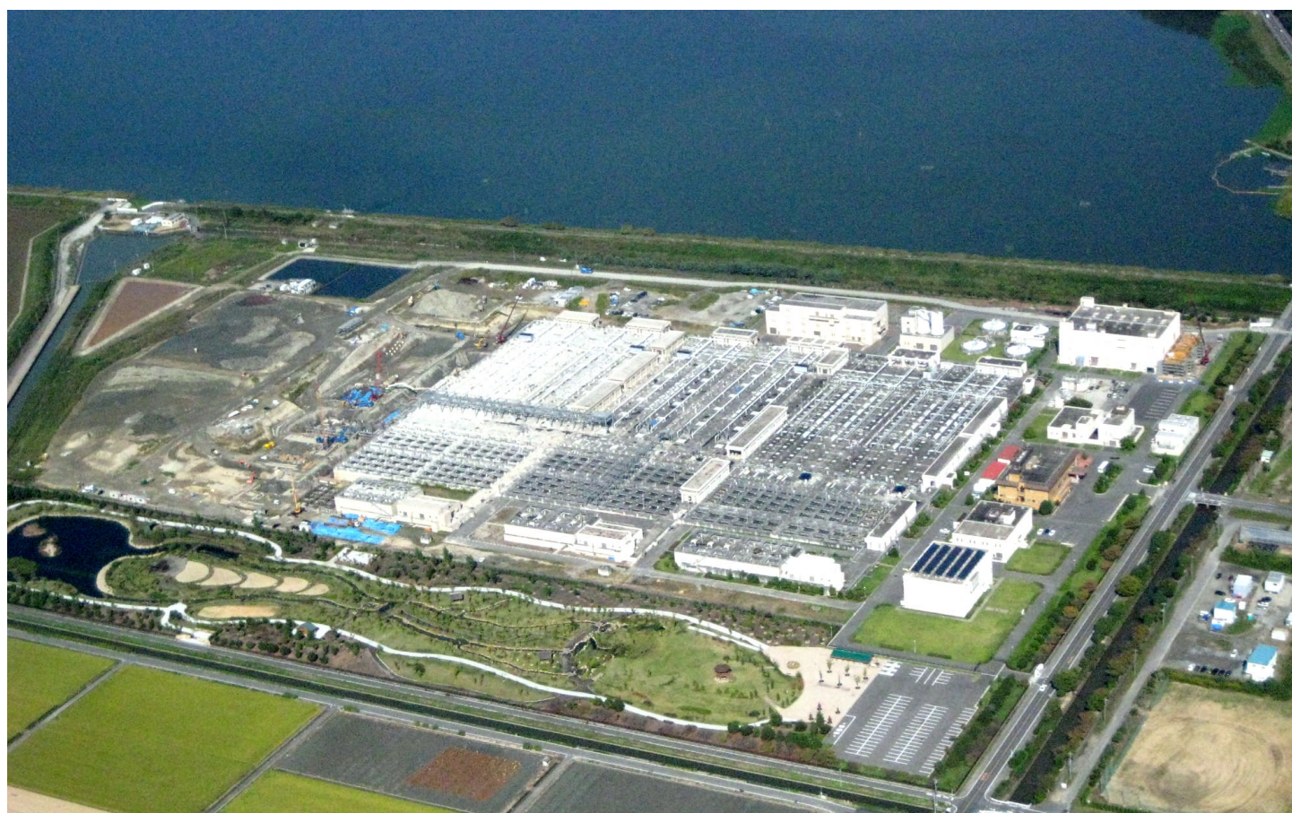
岡山県児島湖流域下水道浄化センター全景
