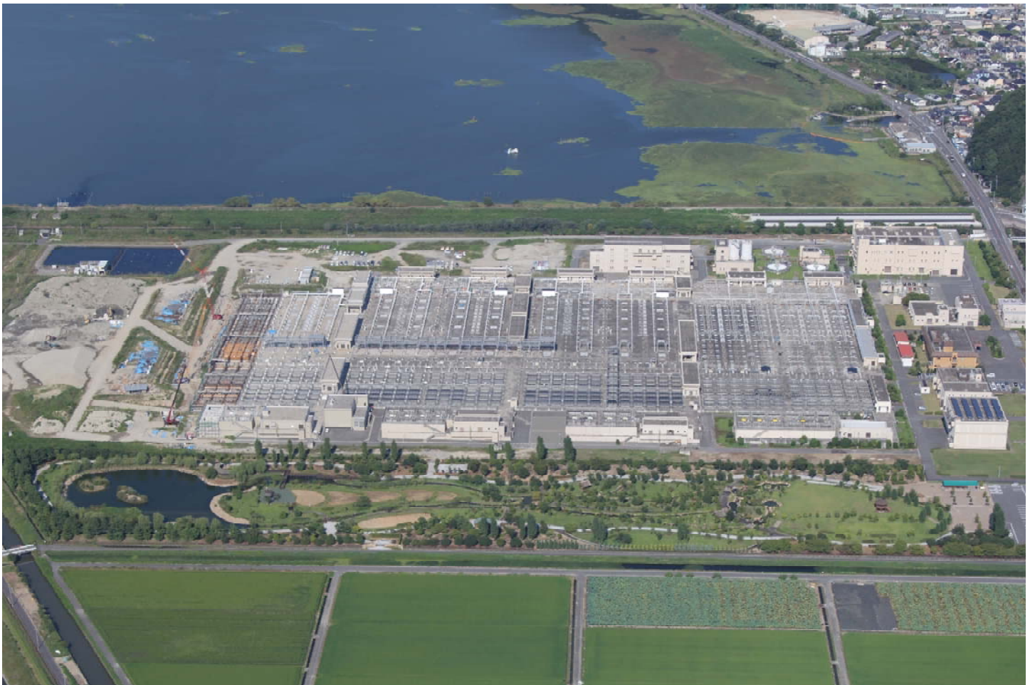
岡山県児島湖流域下水道浄化センター全景
